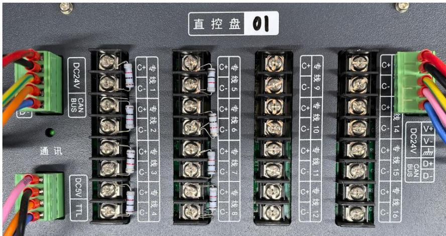
直控盘号：01-13，01号直控盘专线1至专线8端子对应控制器主面板右侧1#至8#直控按钮，专线9至专线16为空端子；02至13号直控盘分别对应扩展的专线盘（直接启动控制盘）；用于连接切换模块，控制重要的联动设备，如消防水泵、防烟/排烟风机，每个端子接一只切换模块，用双绞线连接；
